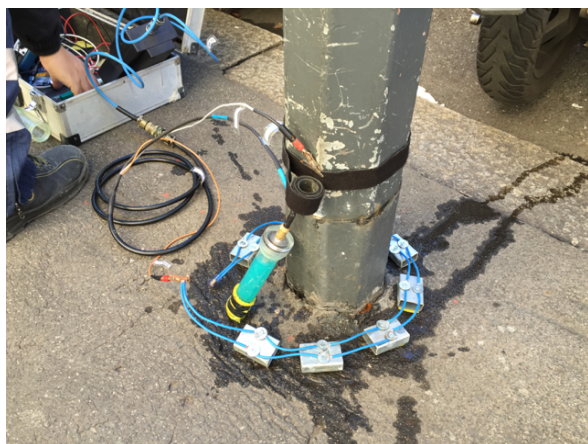
Badanie stanu słupa oświetleniowego
